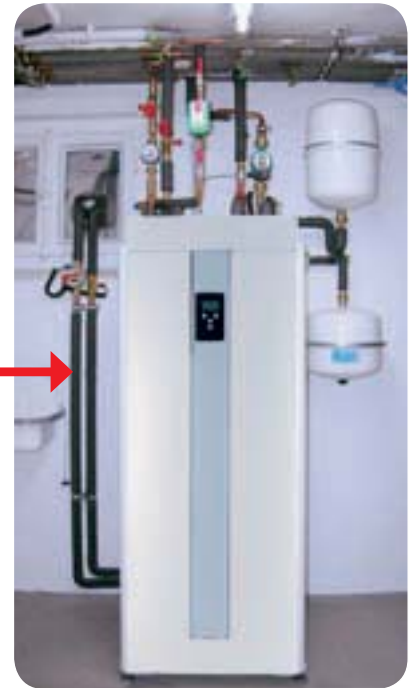
Inneneinheit: Speichermodul
