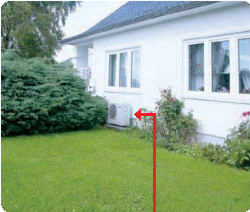
Außeneinheit: Wärmepumpe
